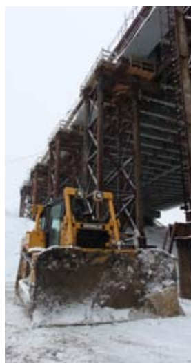
Техника Cat на объекте ООО «Самара Спецмонтаж» (Самарская область)
