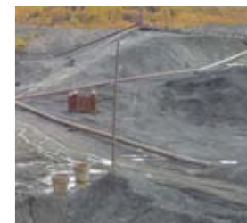
Техника Cat на объекте ОАО «Сусуманзолото» в Магадане
