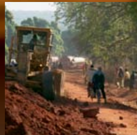
Автогрейдер Cat на отсыпке земляного полотна в Чаде.
